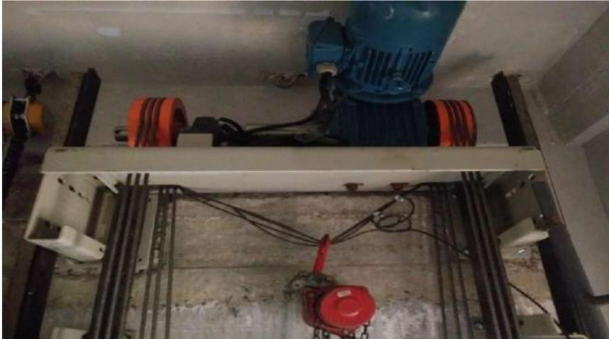
Instalação sem casa de maquinas - maquina do elevador instalado sobre as guias da cabine e suporte fixado na estrutura de concreto.
