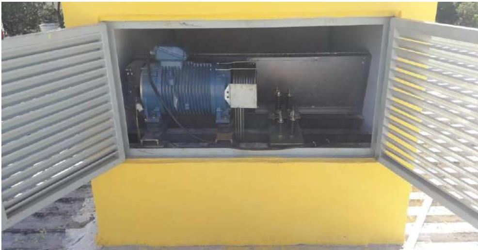
Instalação sem casa de maquinas com janela para manutenção e ventilação com plataforma de segurança.
